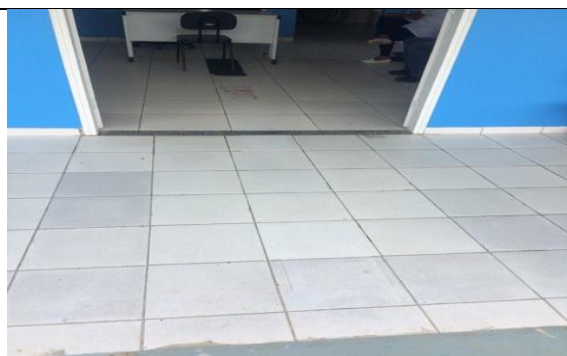
Foto: Piso tátil praticamente inexistente na UBS Nestor Soares de Vasconcelos.
