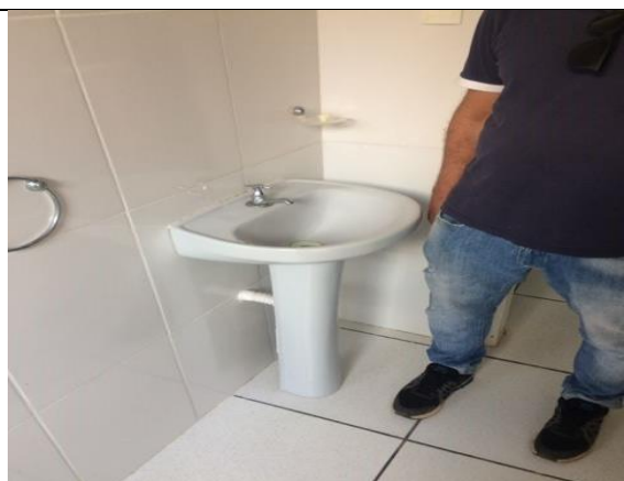
Foto: Lavatório de coluna inteira e sem barra de apoio, na UBS Senador Adalberto Sena.
